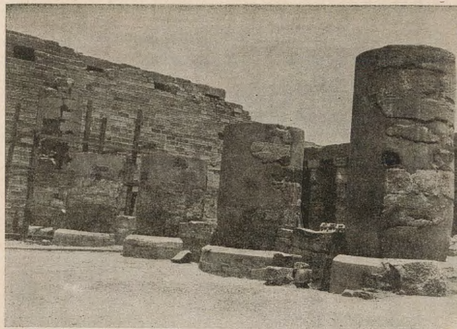
a. — Colonne de Taharqa, après consolidation (rangée nord).
